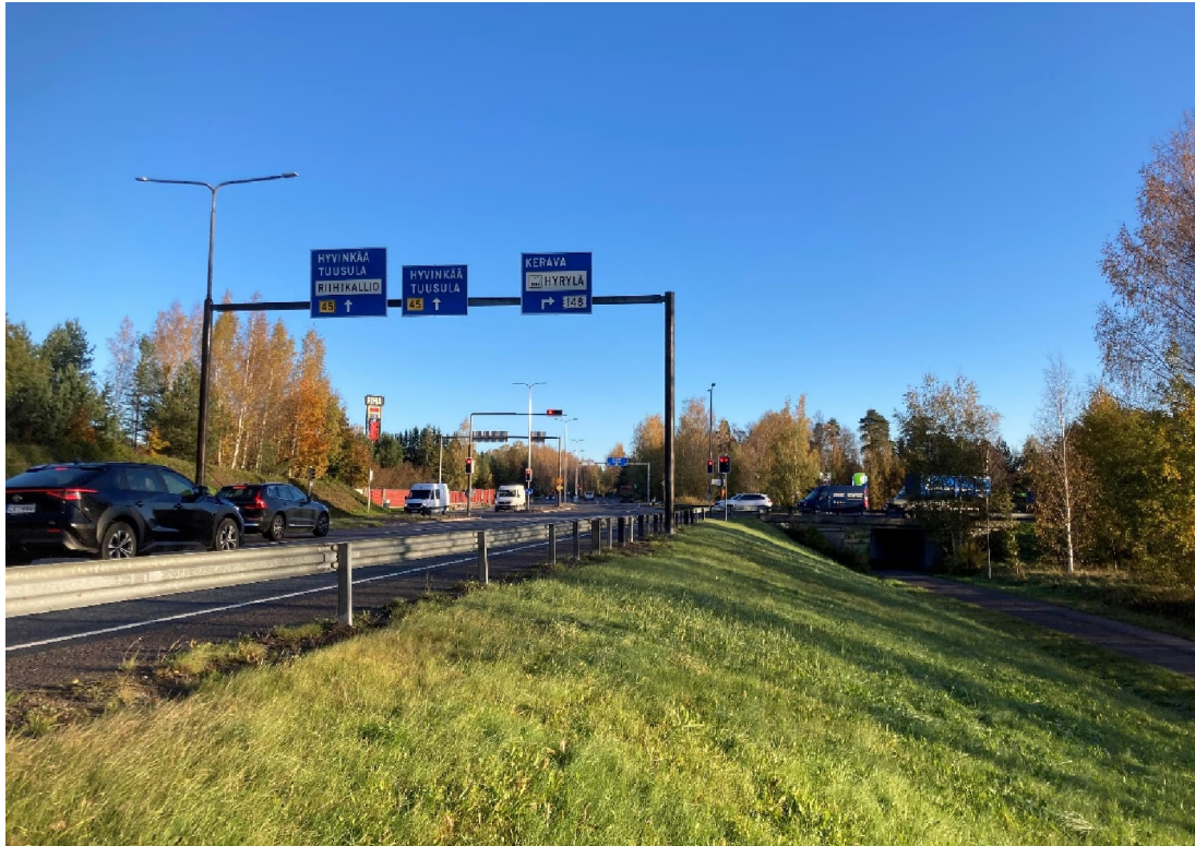
Kuva 2.3. Nykyinen Tuusulan itäväylän liittymä Tuusulanväylällä on liikennevalo-ohjattu ja kiveyksiin kanavoitu tasoliittymä.
