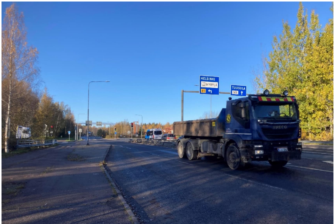
Kuva 2.6. Nykyinen Kulloontien liittymä on valo-ohjattu ja kiveyksiin kanavoitu tasoliittymä.
