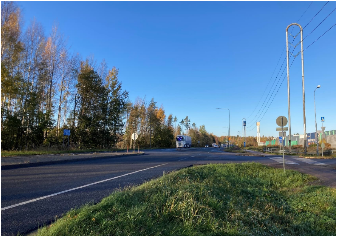
Kuva 2.4. Nykyinen Korvenrannantien liittymä on kiveyksiin kanavoitu tasoliittymä.
